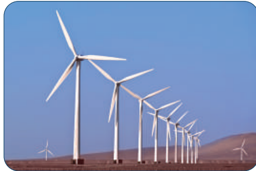
شكل 7-19 توليد الكهرباء باستخدام طاقة الرياح
