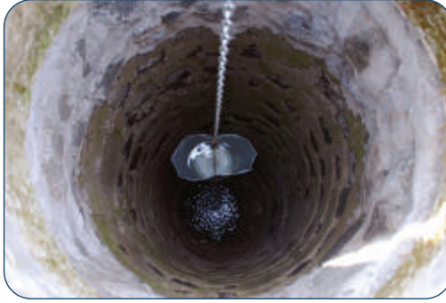
شكل 3-8 آبار المياه الجوفية
