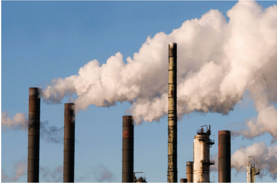
■ الشكل 14-2 الرماد المتصاعد من المدخن نتيجة ثانوية لاحتراق الفحم. ويمكن استعمال مرشحات الترسيب الكهروستاتيكية لتقليل هذا الرماد.
